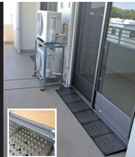
キャスコーナー 70・M 介護施設のバルコニー出入口の段差解消
