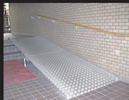
アルミスロープ 700 共用通路部階段のスロープ
