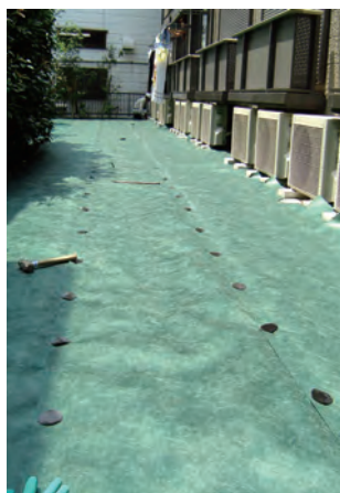
シート敷き～ピン固定完了
