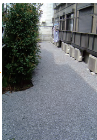
砂利敷き詰め完了
