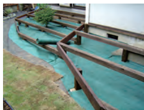
ウッドデッキ下、シート敷き
