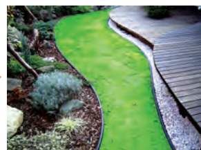
砂利敷き詰め～デッキ完成
