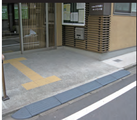
セフティスロープ 100 福祉施設出入口の段差解消
